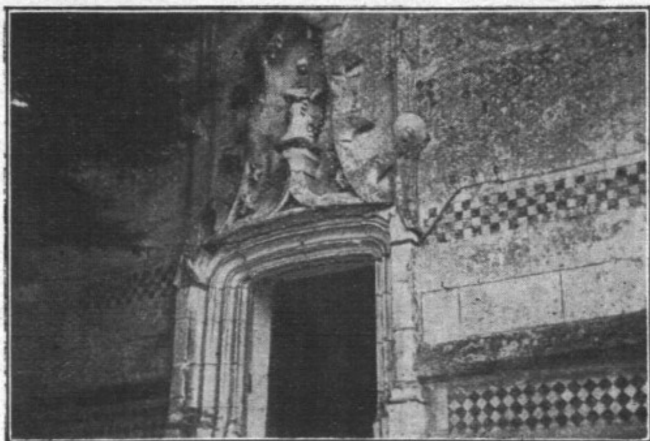
Portail de l'église Saint-Eustache. (Cliché de M. A. Jaulme.)
